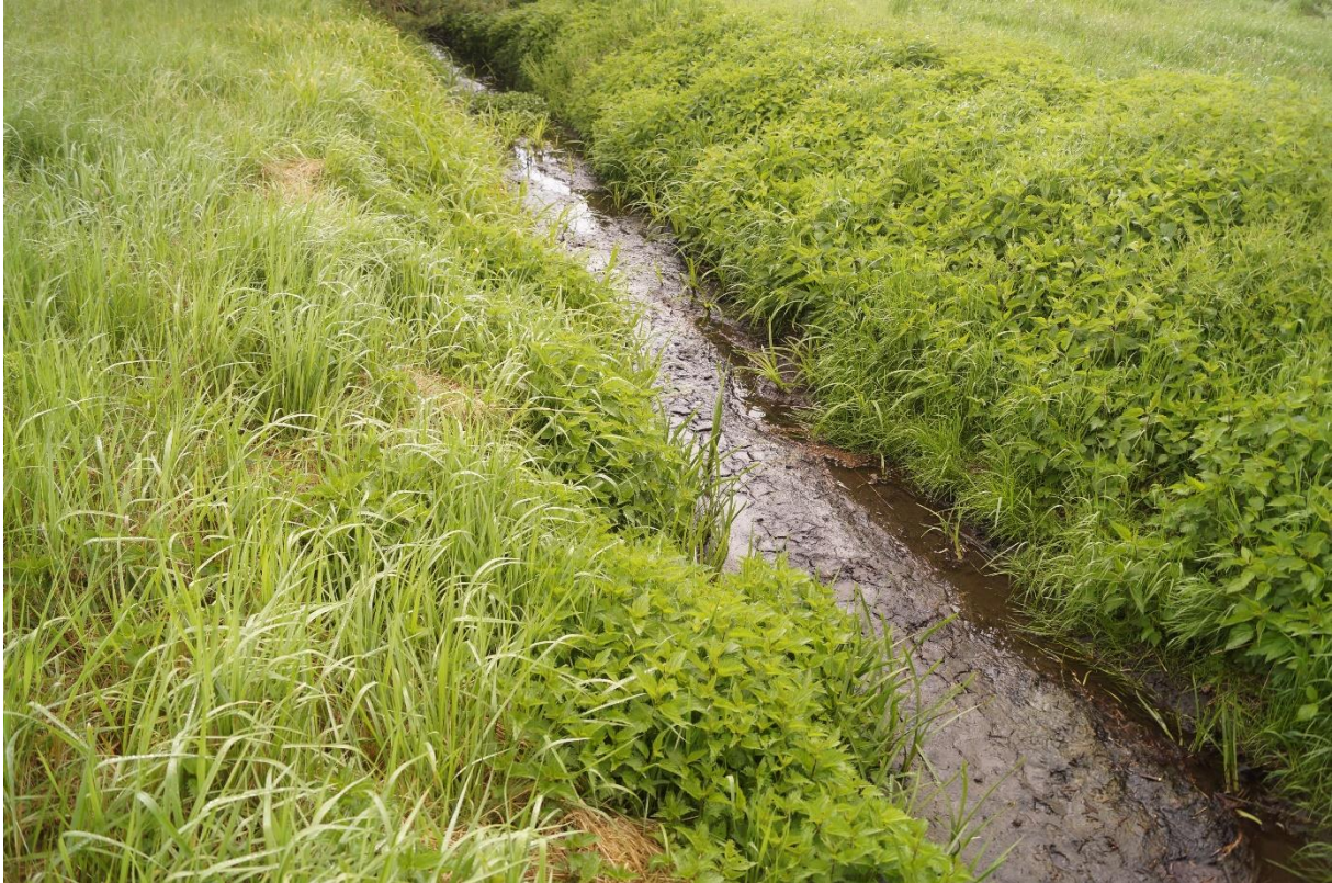
Abb. 12: verschlammter Klingmühler Mühlgraben
