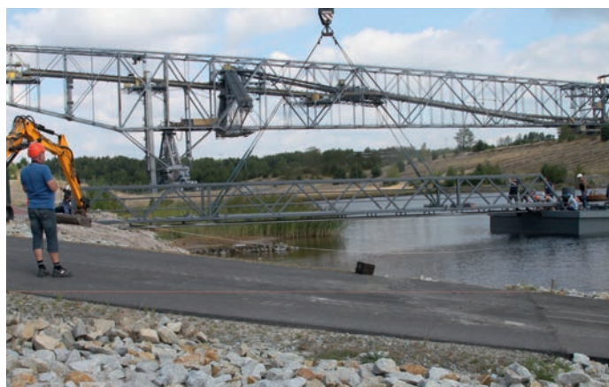
Mitarbeiter der Fa. Wilde Metallbau bei der Befestigung auf dem ersten Ponton
