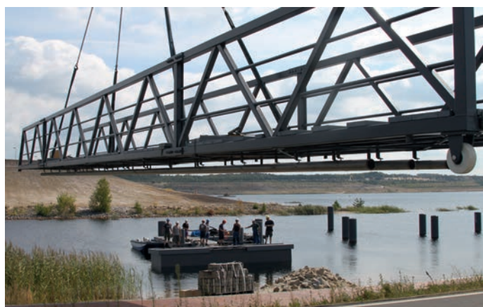
Einschwenken der Steganlage
