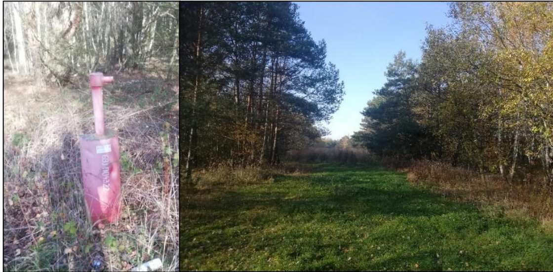
Abb. 3: Aktiver GW-Messbrunnen (links) und ehemalige Filterbrunnenstrecken (rechts)
