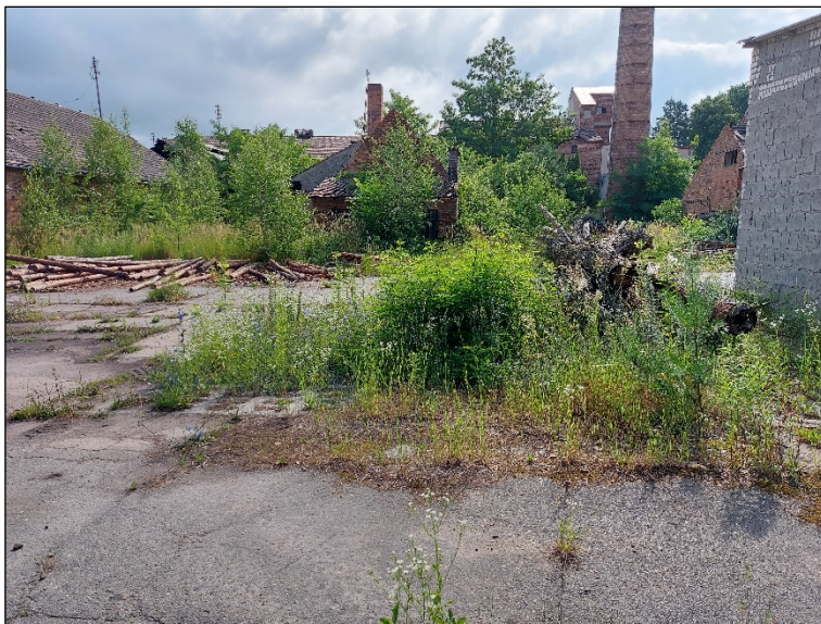
Abbildung 23: Industriebrache im Nordosten des Plangebiets (28.06.2022)
