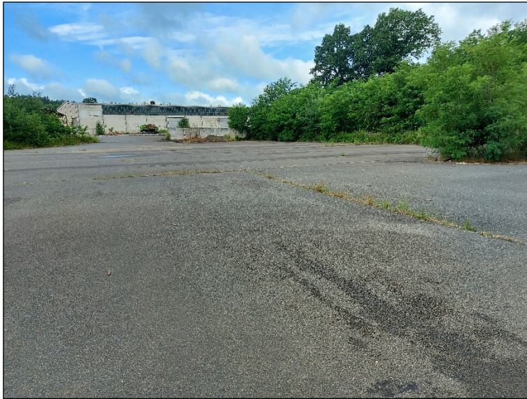
Abbildung 24: Asphaltfläche im Osten des Plangebiets (28.06.2022)
