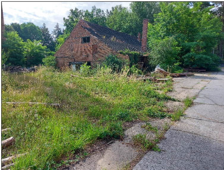
Abbildung 27: Ruine im Nordosten des Plangebiets (28.06.2022)
