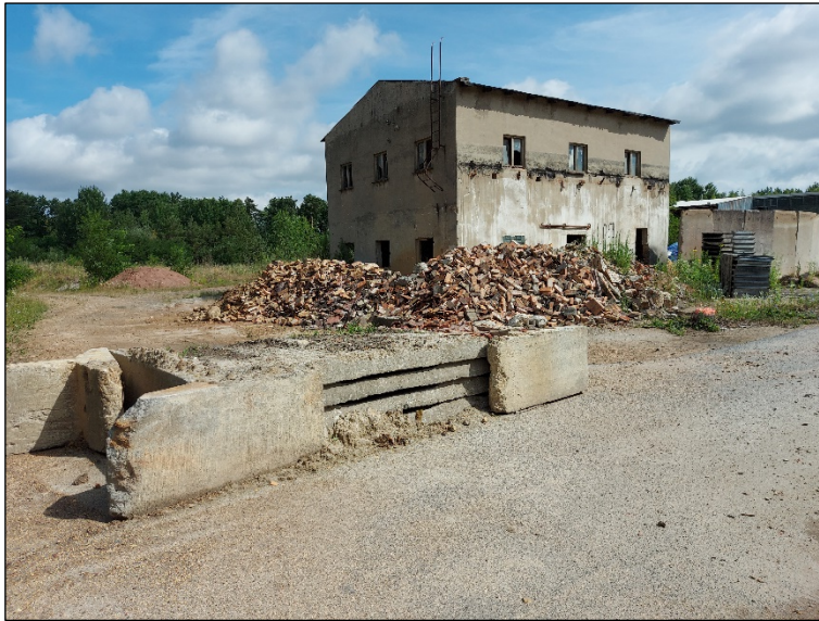
Abbildung 26: Ruine im Westen des Plangebiets (28.06.2022)
